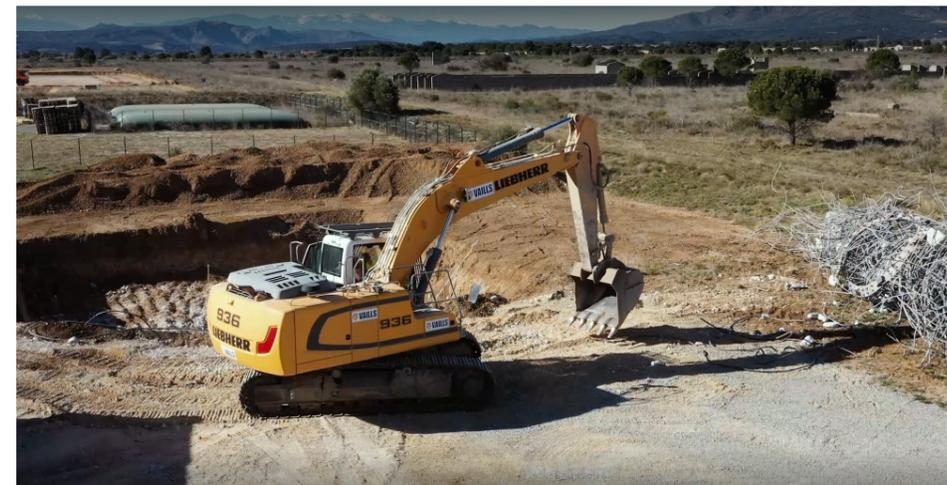
Figure 8 - Séparation du béton de la fondation du ferrillage des fondations - parc éolien de Rivesaltes par GEG ENel
