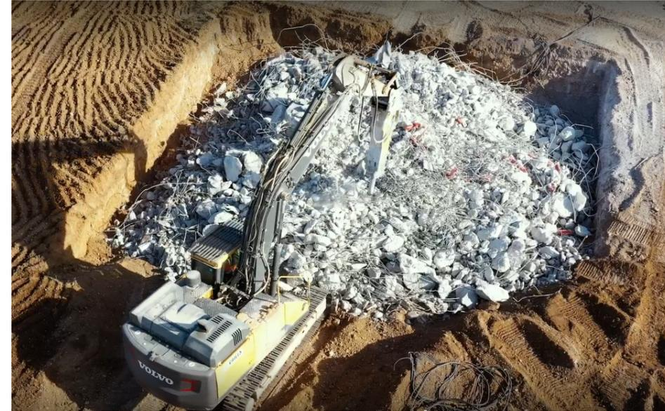
Figure 7 - Fondations de l'éolienne réduit démolie pour être ensuite concassée dans une carrière - parc éolien de Rivesaltes par GEG ENel
