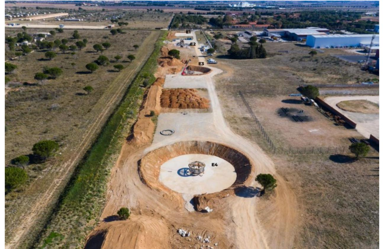
Figure 10 - Vue aérienne du site préparé pour le nouveau chantier d'implantation des nouvelles éoliennes, opération de repowering par GEG ENeR
